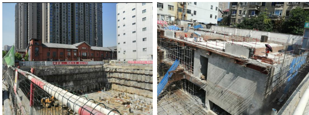
图 8-1 疑难病症诊治综合楼（本项目所在地，在建中）
